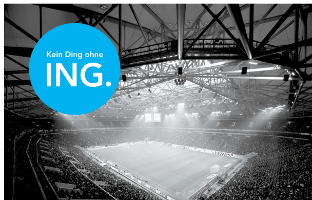
Mehrzweckarena: Ingenieurleistung im Konstruktiven Ingenieurbau
